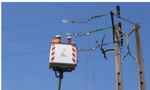
M. Jean-Marie BELLARD a sectionné un des 3 câbles.
